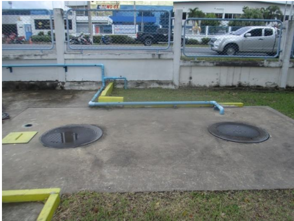
บ่อพักน้ำทิ้ง (ก่อนระบายไปยัง Sump pit 1)
