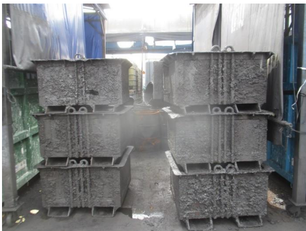
รูปที่ 2-25 รางดักน้ำมันบริเวณด้านหน้าของโรงเก็บขยะ (ภายใต้หลังคา)
