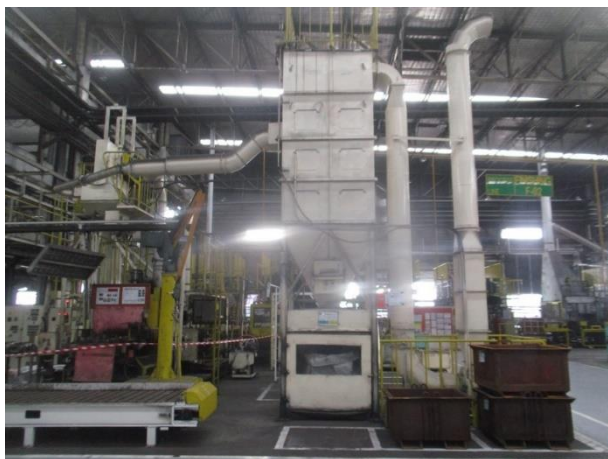
รูปที่ 2-39 Big bag เพื่อรองรับฝุ่นละอองจากการเคาะฝุ่นออกเป็นจังหวะของระบบถุงกรองของเครื่องตัดผิวชิ้นงาน และมีตัวปิดมิดชิด
